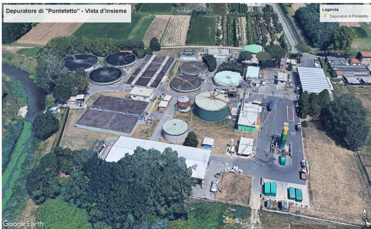
Figura 2 – Vista d'insieme dell'impianto di depurazione di "Pontetetto" (LU)
